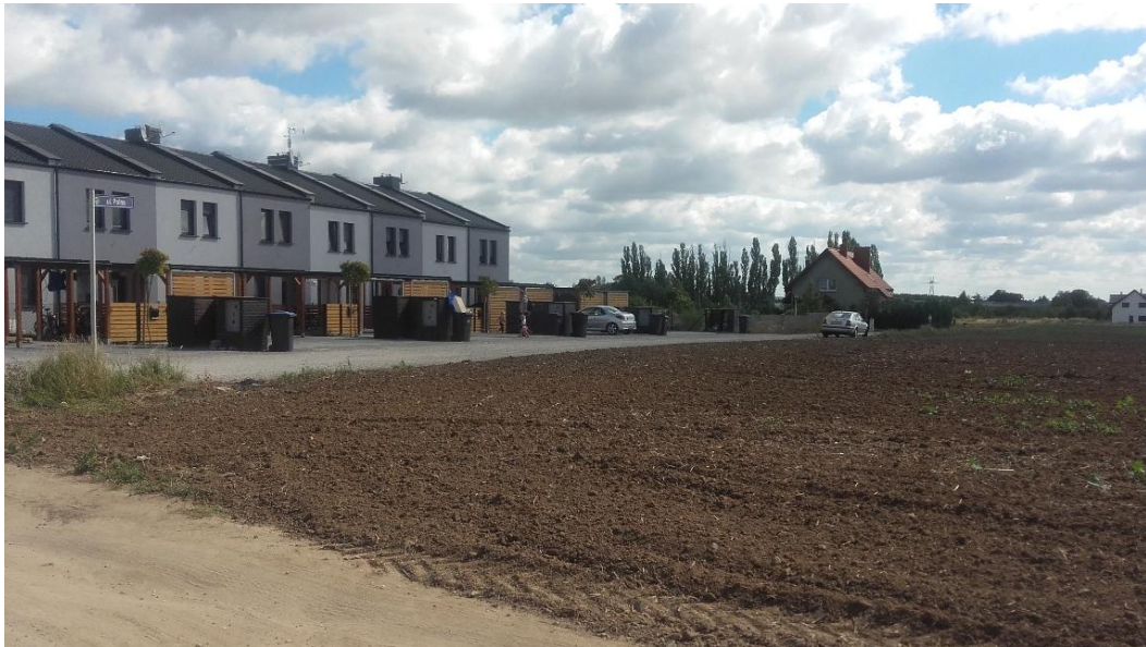
Ryc. 8. Widok z ul. Zielonej na zabudowę mieszkaniową szeregową zlokalizowaną poza obszarem opracowania planu przy ulicy Polnej
